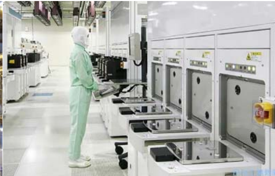
半導体装置の真空ポンプ
